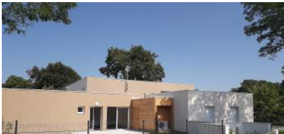
Logements collectifs en PLAI adapté à destination de familles Gens du voyage à Blanquefort (Les Gravières) Source : site internet ADAV33
