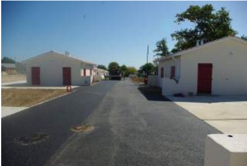
Construction des terrains familiaux de Cenon-Artigues en 2011 (source : DDTM de la Gironde)
